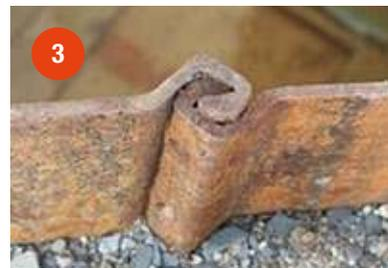
giunzioni oppure preparare (come da foto 1), già assemblate, le palancole con prodotti idroespansivi o impermeabili. Per contrastare la corrosione, per contatto con acque dolci o acque salate, vengono zincate o verniciate. Le palancole che si trovano in commercio devono essere fornite in accordo alle seguenti normative di riferimento:
