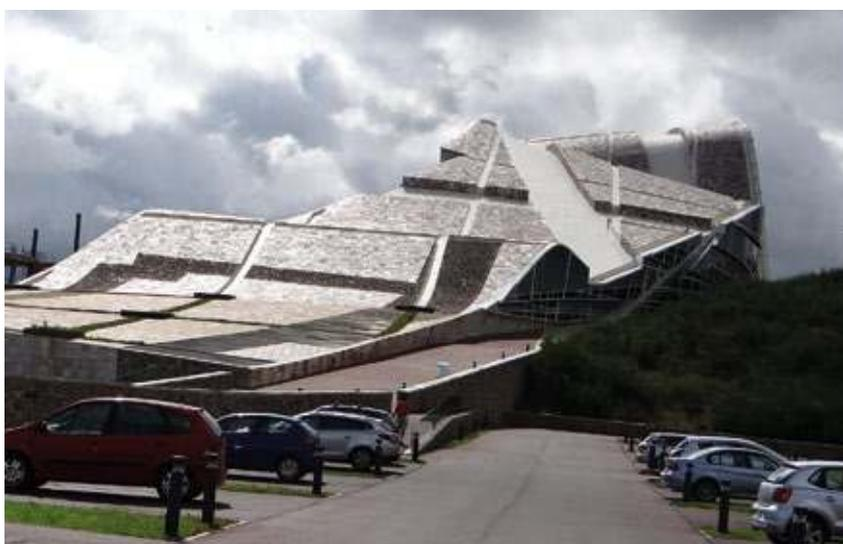
cangianti nei differenti momenti della giornata e compongono vere e proprie griglie litiche, interrotte solo da grandi vetrate. Dalle coperture lo smaltimento dell'acqua piovana avviene attraverso le fughe del reticolo geometrico a diretto contatto con la struttura in c.a.
