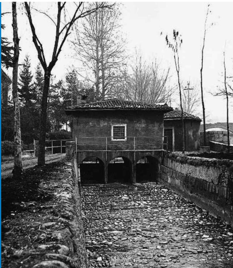
superato il quale si trova una vasca di carico. Tale struttura è in grado oggi di accogliere un apporto massimo di acqua pari a  $9 \text{ m}^3/\text{s}$ , non costante a causa del regime irregolare del Serio.
