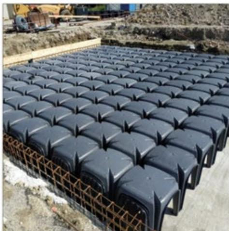
*Sistema modulare misto in plastica e cemento*
